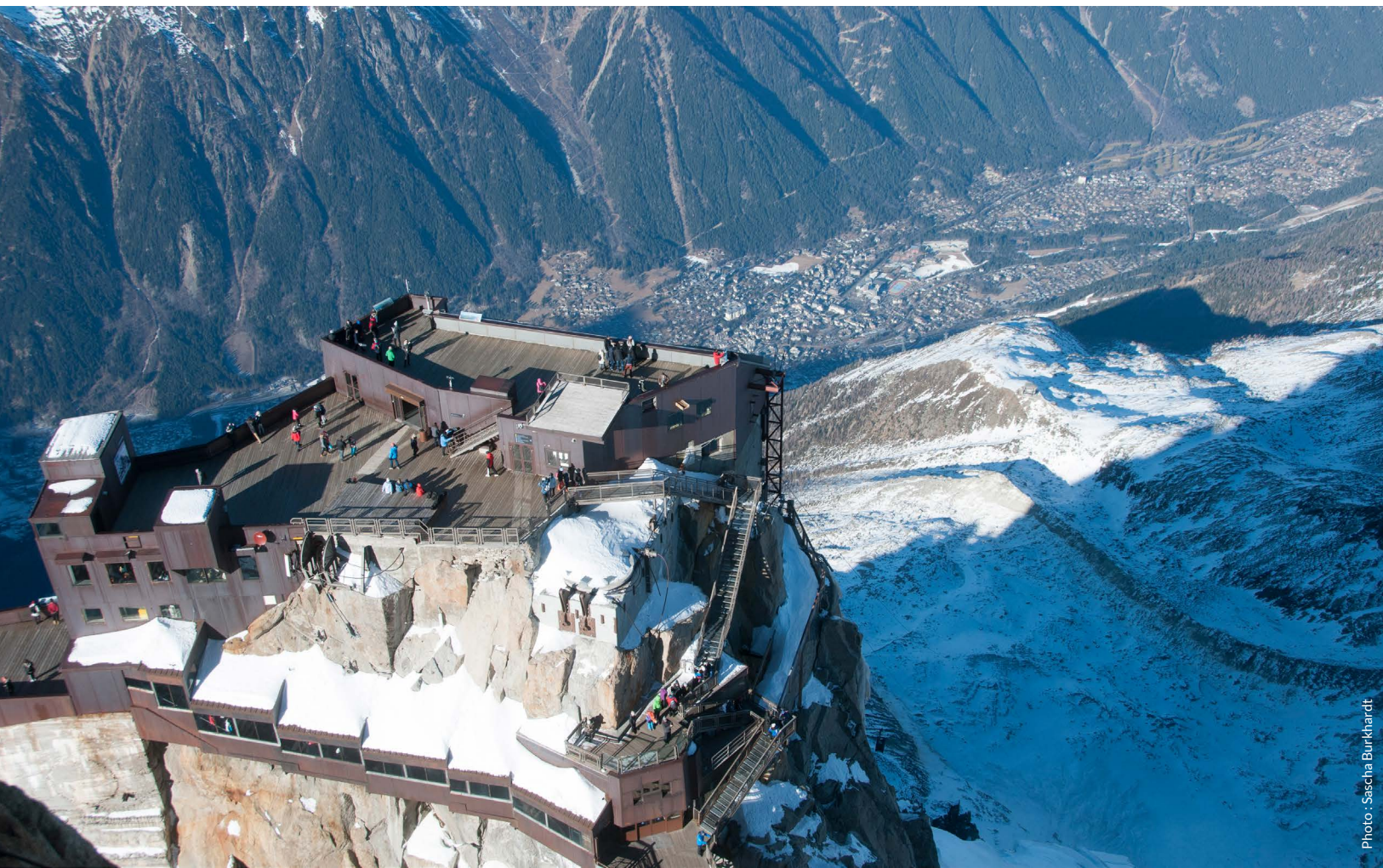
Un balcon à 2 800 m au-dessus de Chamonix et adossé au Mont-Blanc : les plateformes de l'Aiguille du Midi.
